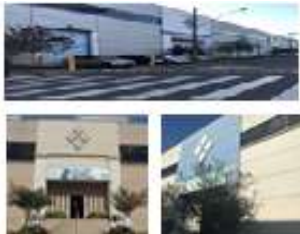
CEA Atibaia / Jarinú, SP Av. Tégula, 888, Ponte Alta Área Construída: 28.797 m 2 Participação: 100%
