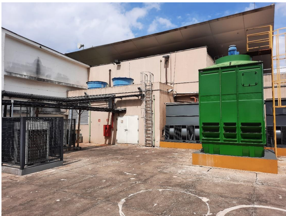
Área técnica (cobertura)
