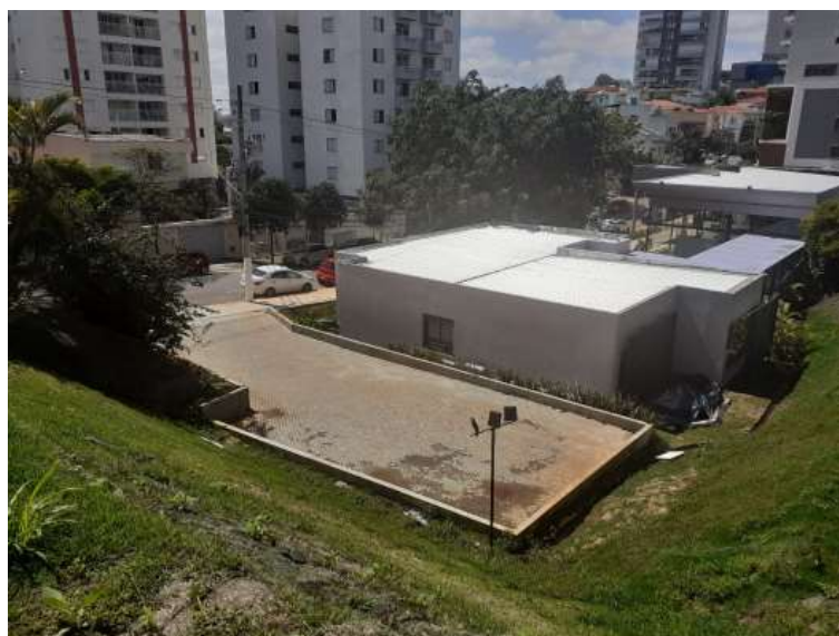
Vista interna do imóvel
