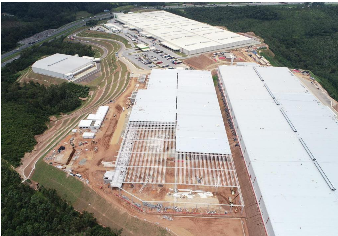
Execução de obras – Foto Panorâmica
