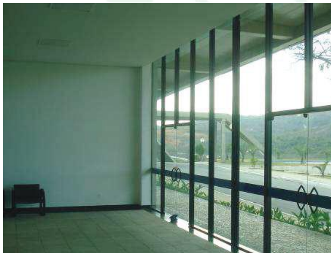
Foto 21: Vista interna do Velório 01
