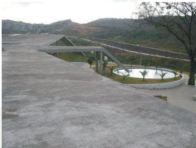
Foto 14: Vista superior da entrada para os Velórios
