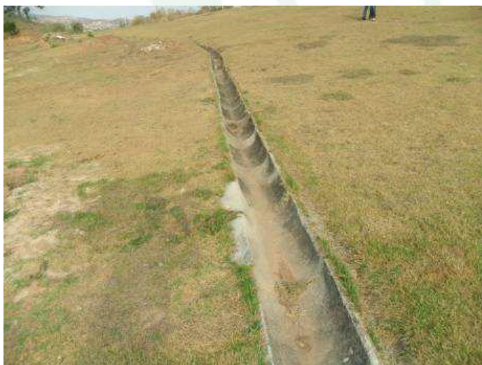
Foto 11: Detalhe da área de escoamento pluvial
