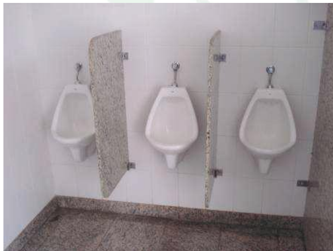
Foto 29: Vista interna sanitário masculino
