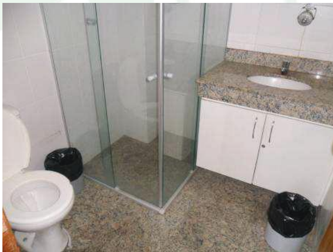
Foto 24: Banheiro com chuveiro
