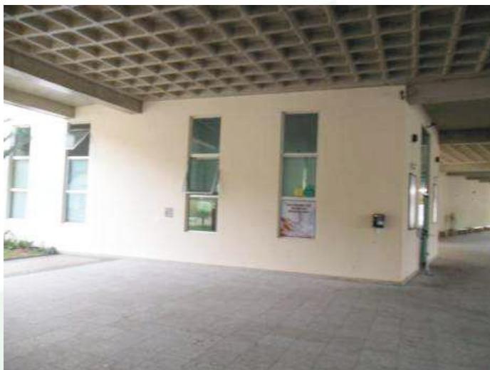
Foto 17: Hall de entrada para os Velórios
