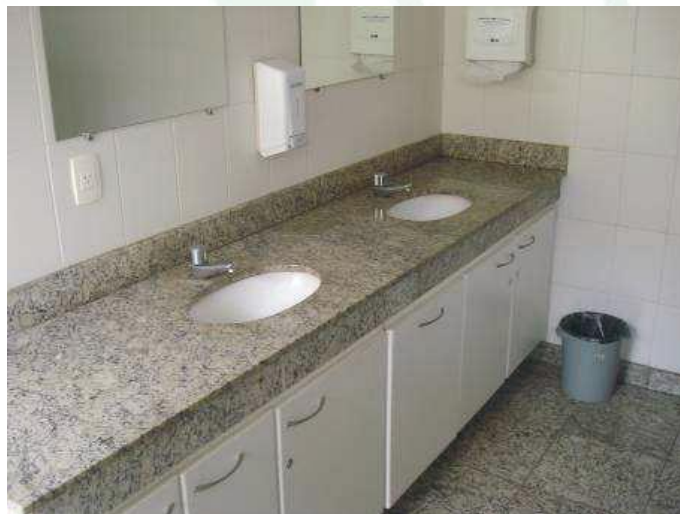
Foto 27: Sanitário com detalhe da bancada
