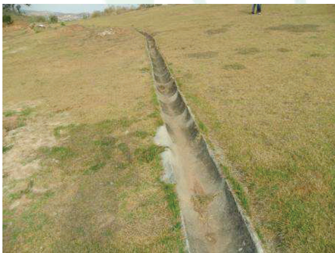
Foto 11: Detalhe da área de escoamento pluvial
