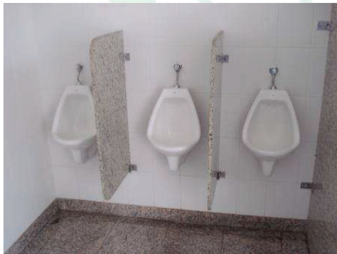
Foto 29: Vista interna sanitário masculino
