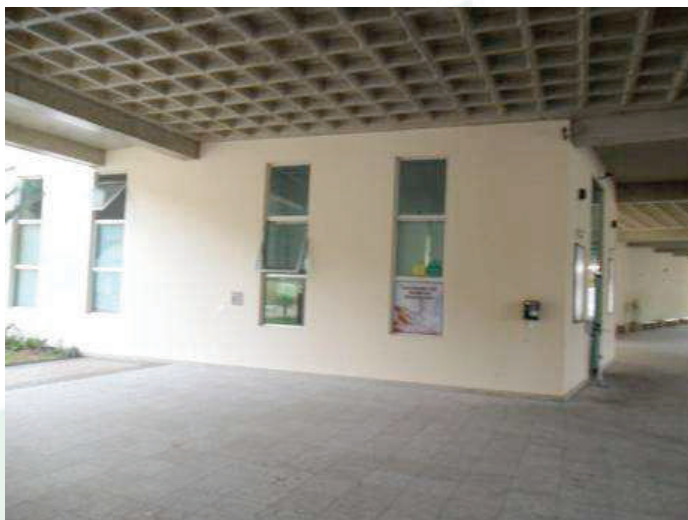
Foto 17: Hall de entrada para os Velórios
