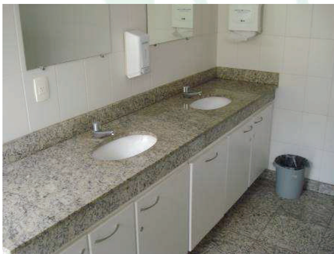
Foto 27: Sanitário com detalhe da bancada
