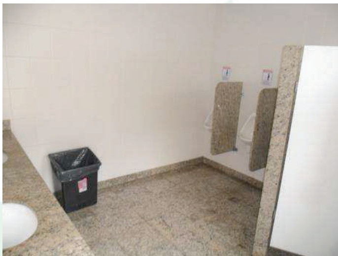
Foto 28: Vista interna sanitário masculino
