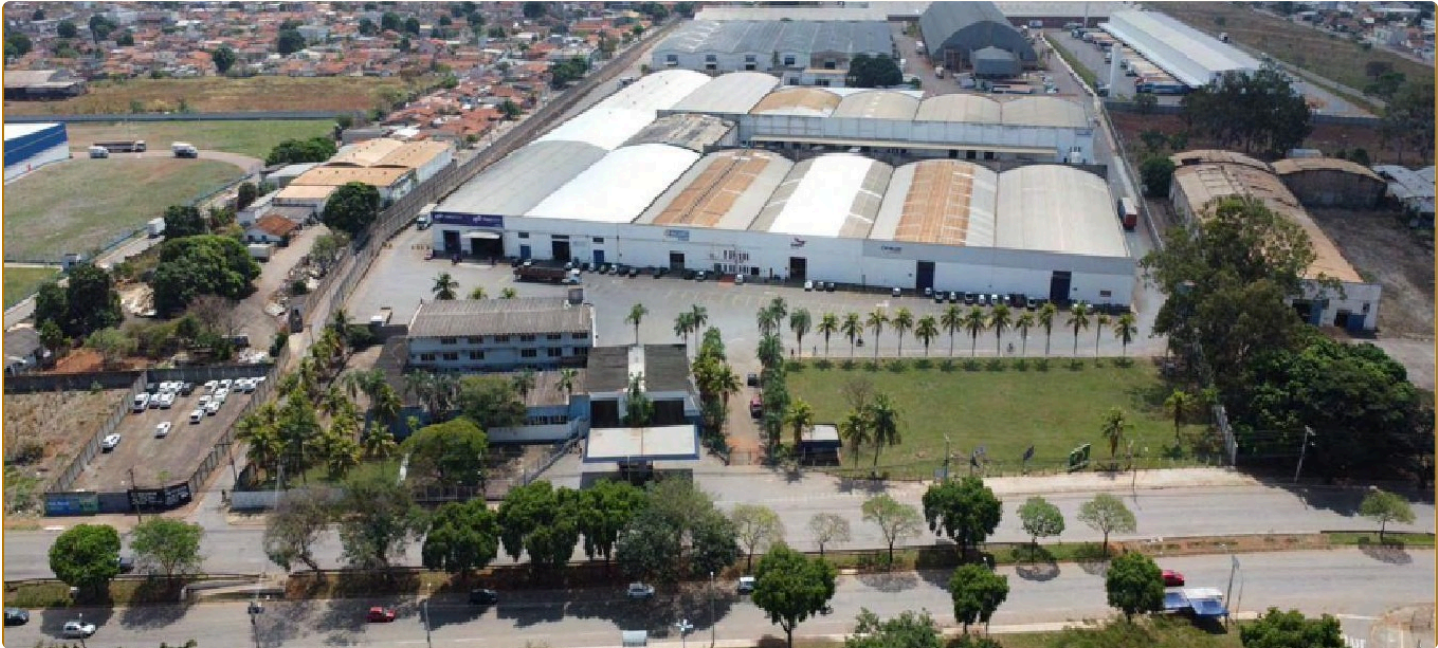
Complexo logístico da Aspam, Avenida Perimetral Norte, 10.002, Vila João Vaz, Goiânia, GO.
