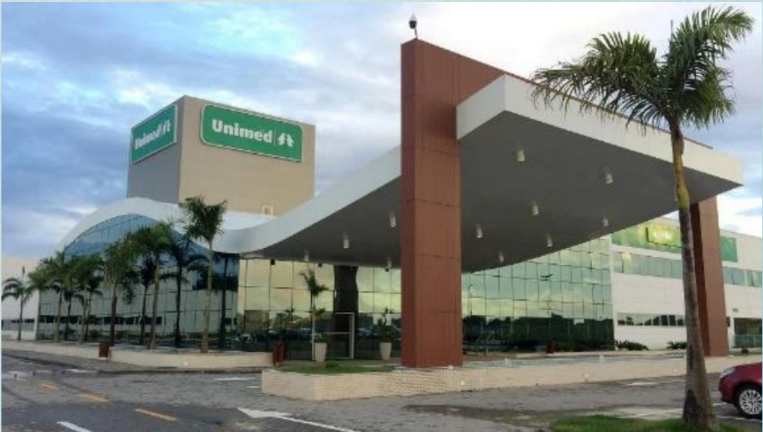
O FII é proprietário de um empreendimento localizado na Rodovia Cachoeiro-Safra, no município de Cachoeiro de Itapemirim. O hospital tem 11.577 m 2 e cerca de 130 leitos.
