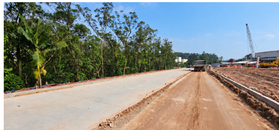
CD Raposo Sanca - Terraplanagem
