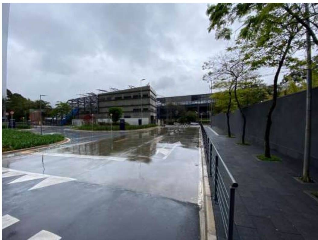
VIA DE ACESSO: RUA ANTÔNIO DE OLIVEIRA
