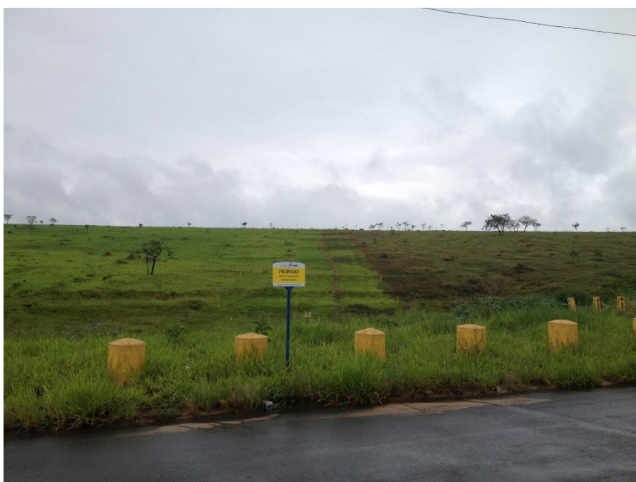
Vista da servidão de passagem de Gasoduto
