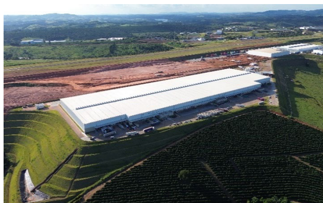
Imagem aérea do empreendimento.
