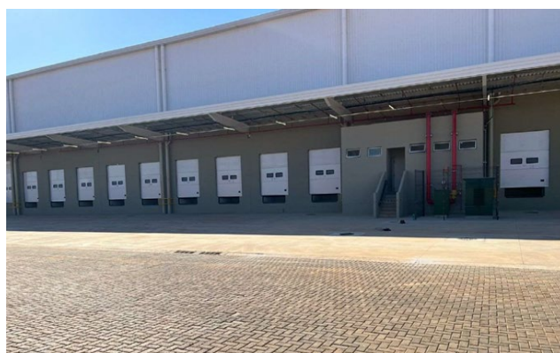
Docas e sanitários do galpão.
