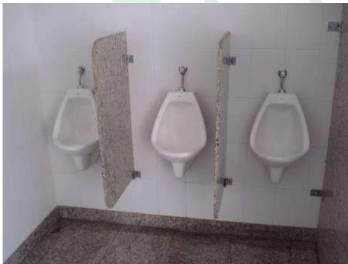
Foto 29: Vista interna sanitário masculino
