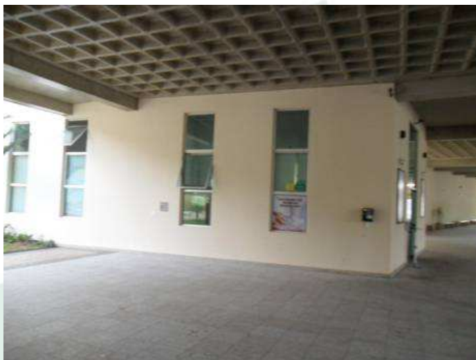
Foto 17: Hall de entrada para os Velórios
