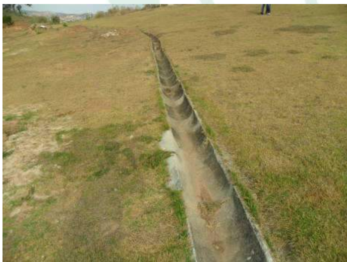
Foto 11: Detalhe da área de escoamento pluvial
