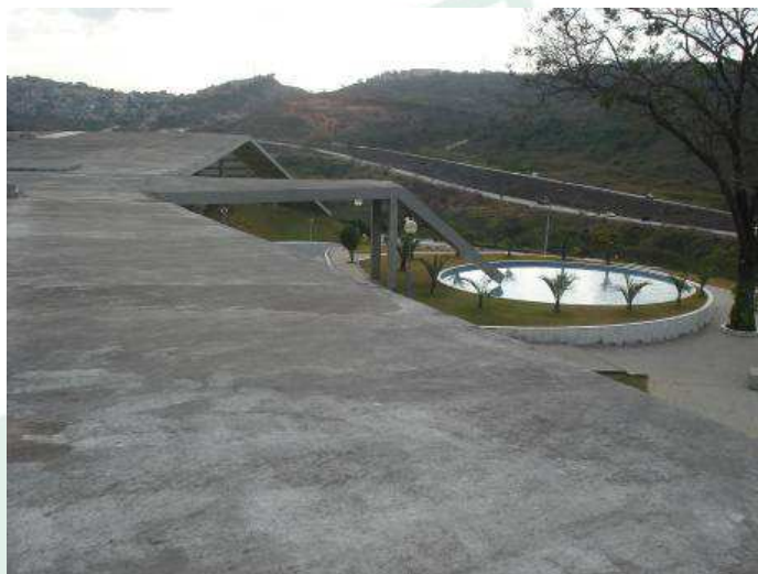
Foto 14: Vista superior da entrada para os Velórios
