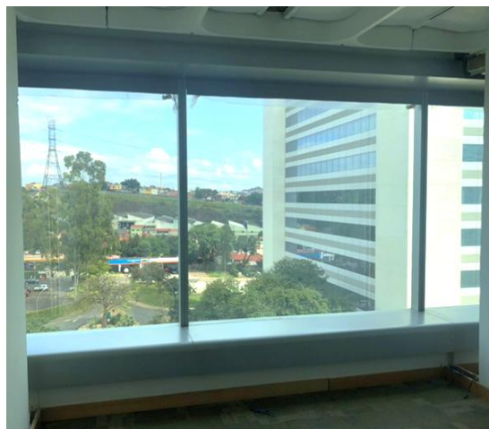
Vista Externa – Andar Tipo
