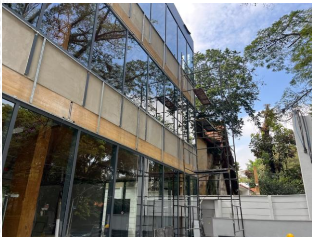
Estruturação para ACM da fachada compartimentada
