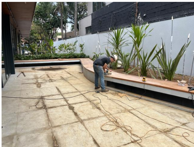
Instalação de revestimento de banco em madeira
