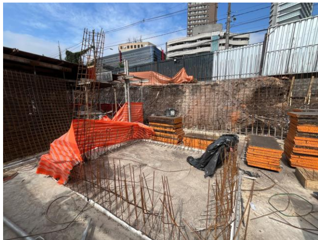
Arranques do reservatório - Torre Pedroso
