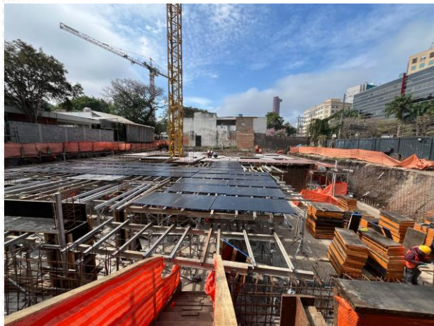
Forma e escoramento da laje - Torre Pedroso
