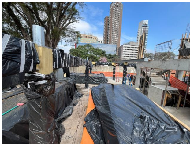
Instalação vigas metálicas e pilares de madeira - Torre Ferreira
