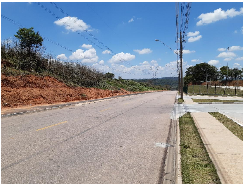
Avenida Francisco Roveri, com o imóvel à direita
