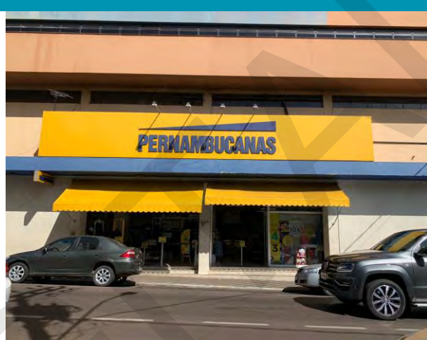
ASPECTOS GERAIS DA FACHADA DO IMÓVEL
