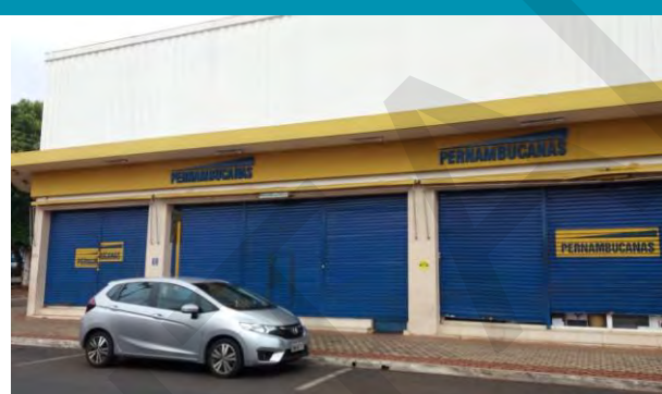
ASPECTOS GERAIS DA FACHADA DO IMÓVEL
