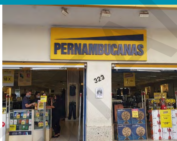
ASPECTOS GERAIS DA FACHADA DO IMÓVEL
