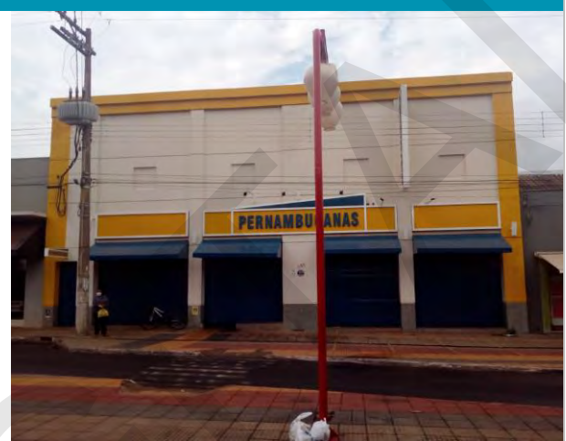
ASPECTOS GERAIS DA FACHADA DO IMÓVEL
