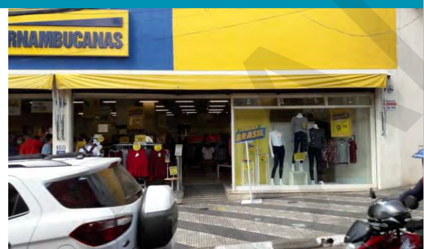
ASPECTOS GERAIS DA FACHADA DO IMÓVEL
