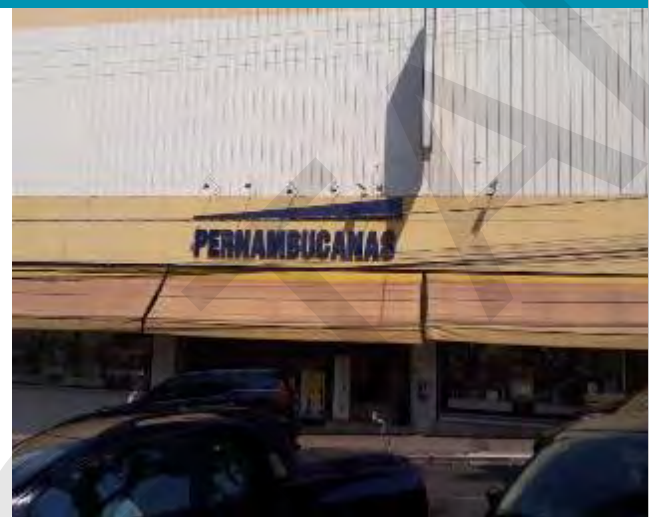
ASPECTOS GERAIS DA FACHADA DO IMÓVEL
