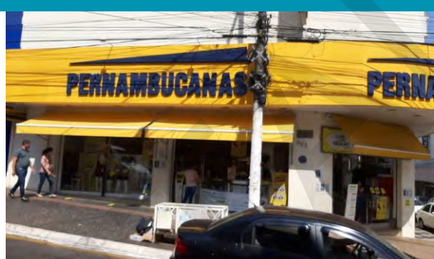
ASPECTOS GERAIS DA FACHADA DO IMÓVEL
