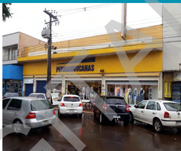
ASPECTOS GERAIS DA FACHADA DO IMÓVEL
