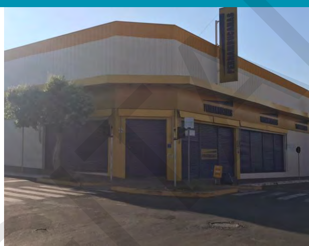
ASPECTOS GERAIS DA FACHADA DO IMÓVEL
