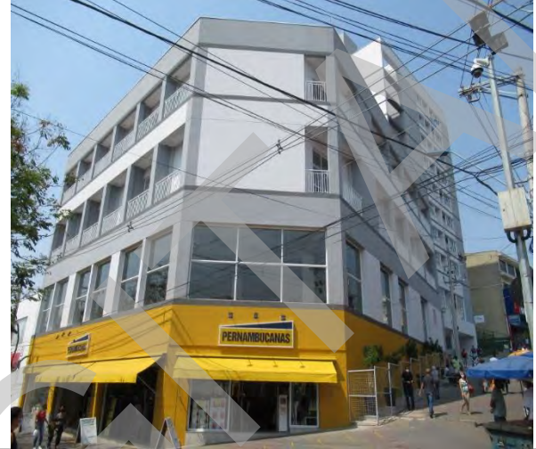
ASPECTOS GERAIS DA FACHADA DO IMÓVEL
