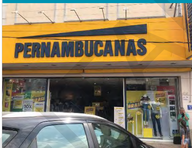
ASPECTOS GERAIS DA FACHADA DO IMÓVEL
