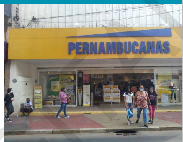
ASPECTOS GERAIS DA FACHADA DO IMÓVEL
