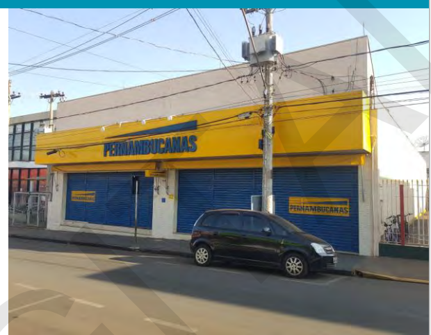
ASPECTOS GERAIS DA FACHADA DO IMÓVEL
