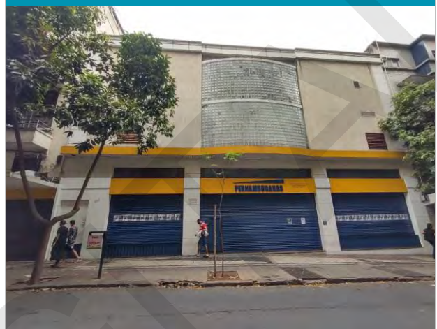
ASPECTOS GERAIS DA FACHADA DO IMÓVEL
