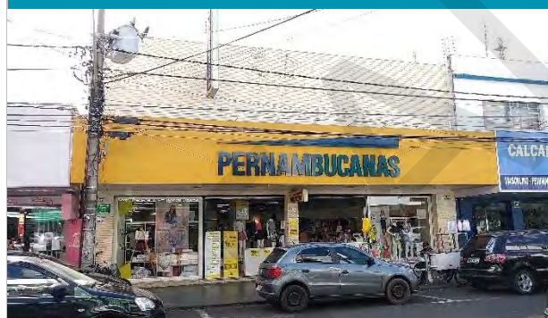
ASPECTOS GERAIS DA FACHADA DO IMÓVEL
