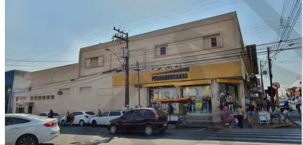
ASPECTOS GERAIS DA FACHADA DO IMÓVEL
