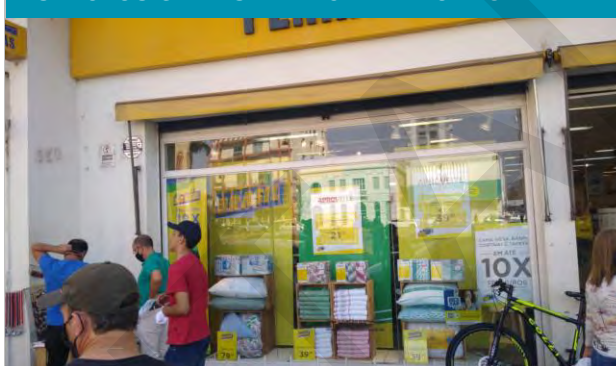
ASPECTOS GERAIS DA FACHADA DO IMÓVEL
