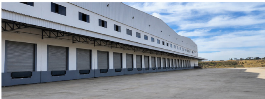
CD SantaCruz - Área Externa do Galpão
