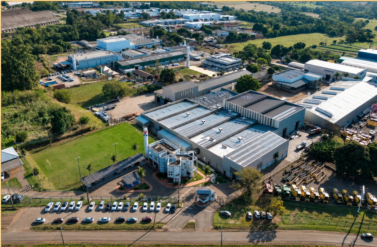
Indústria e Sede da Visolux localizada em Maringá - PR
