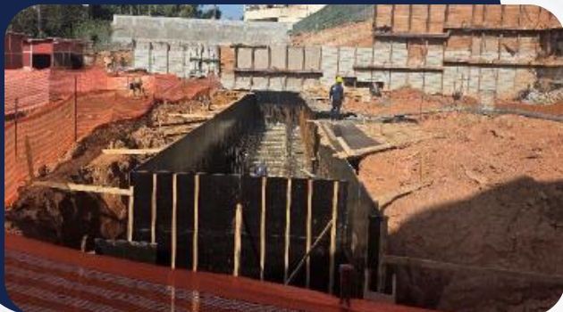
Foto 1: Bloco de Fundação
