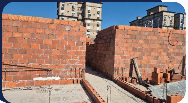
Foto 5: Andamento da obra
