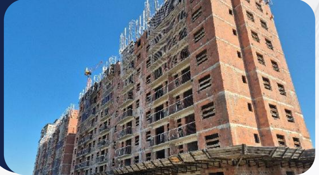
Foto 2: Andamento da obra
