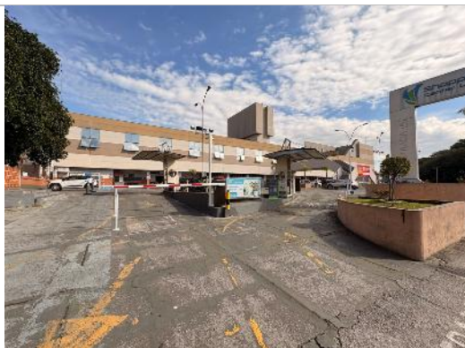
Acesso de veículos
