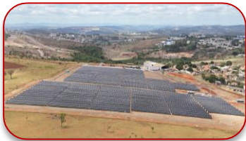
Matozinhos I Cemig - MG 3.3 MWp
