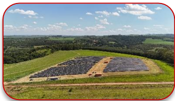
Pirassununga Elektro - SP 3.4 MWp
