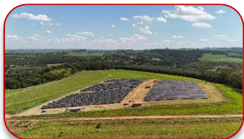
Pirassununga Elektro - SP 3,4 MWp
