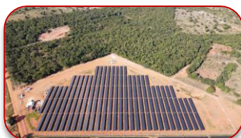
Poconé Energisa - MT 3.4 MWp
