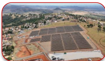
Matozinhos II Cemig - MG 3,3 MWp
