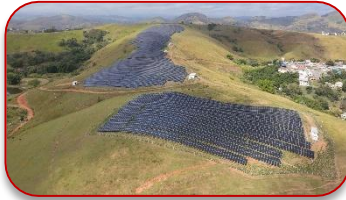
Angra Light - RJ 4,6 MWp
