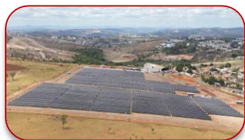
Matozinhos I Cemig - MG 3,3 MWp
