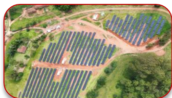
Ouro Fino Cemig - MG 3,3 MWp
