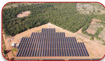
Poconé Energisa - MT 3,4 MWp
