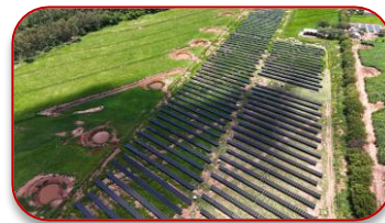
Soleil Copel - PR 3,4 MWp
