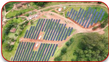
Ouro Fino Cemig - MG 3.3 MWp
