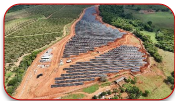
São Bento Abade Cemig - MG 7.0 MWp
