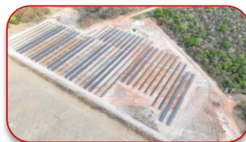
Canoa Quebrada Energisa - MT 6,1 MWp
