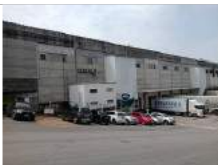
Fachada Frontal Galpão C
