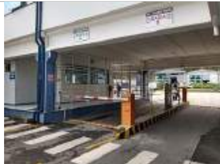
Guarita de controle de acesso
