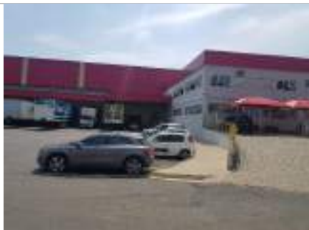
Vista externa do Bloco II
