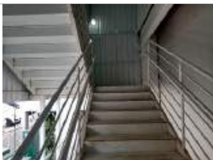
Escada de Acesso
