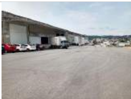
Pátio de manobras
