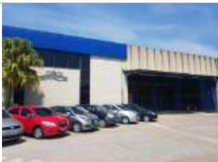
Acesso ao Galpão
