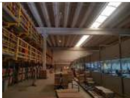
Vista Geral Controle / Armazenamento
