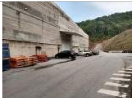
Fachada Lateral Galpão C
