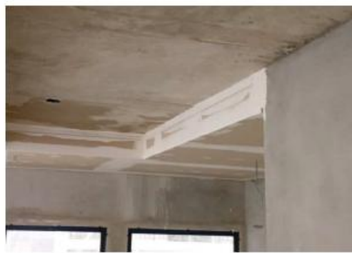
FORRO DE GESSO 10º PAVIMENTO
