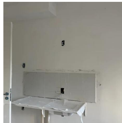
Vista interna unidade
