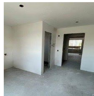
Vista interna unidade
