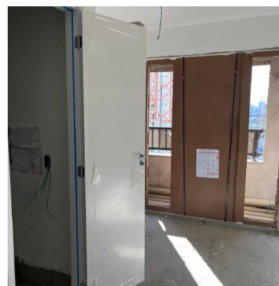
Vista interna unidade
