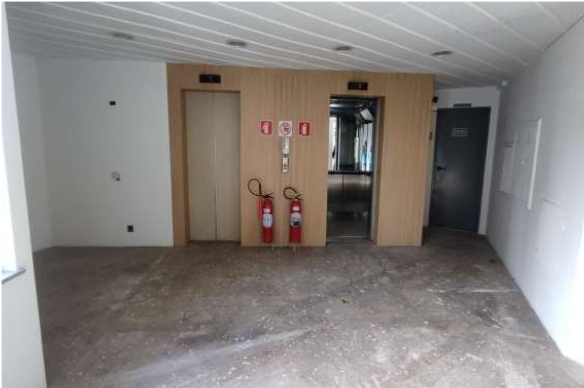
9º andar – área comum do elevador será utilizada para o andar
