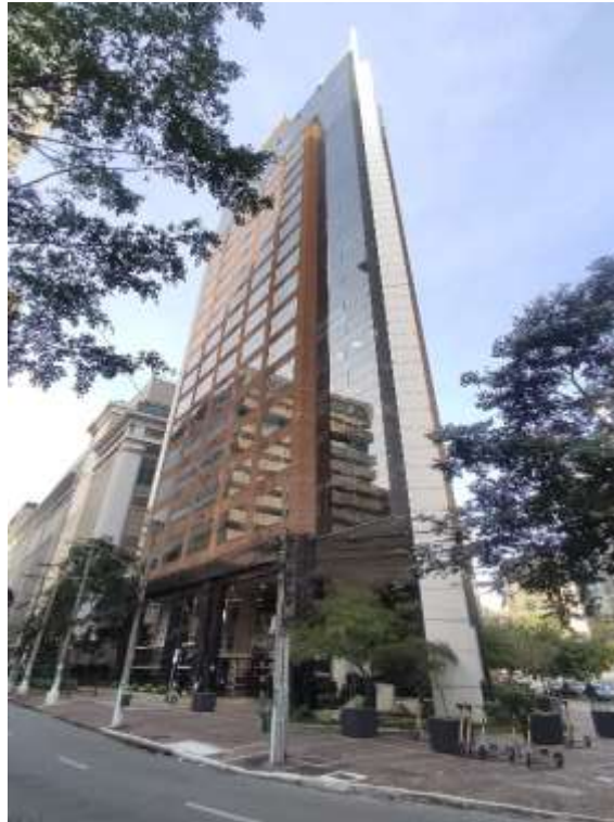
Fachada do Edifício
