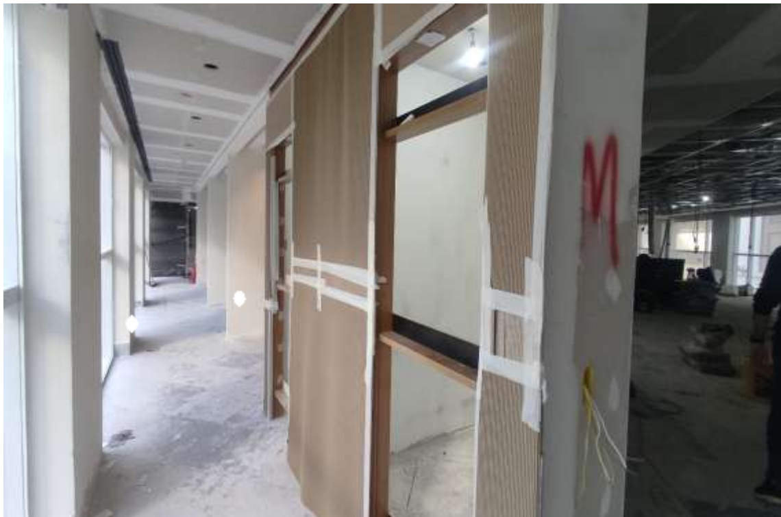
Conjunto 21 – situação atual
