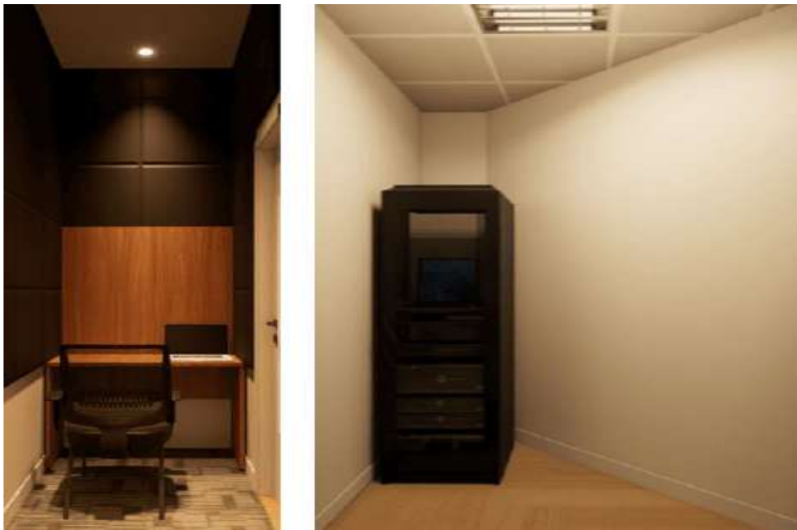
Estação de trabalho – Sala servidor
