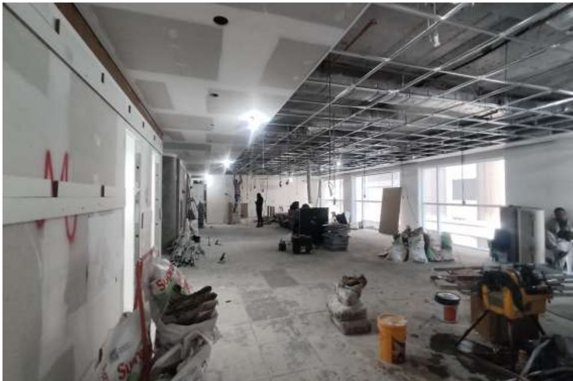
Conjunto 21 – situação atual
