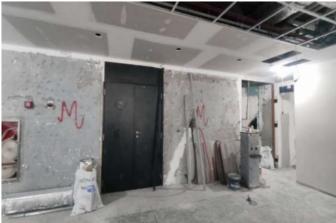
Conjunto 21 – situação atual
