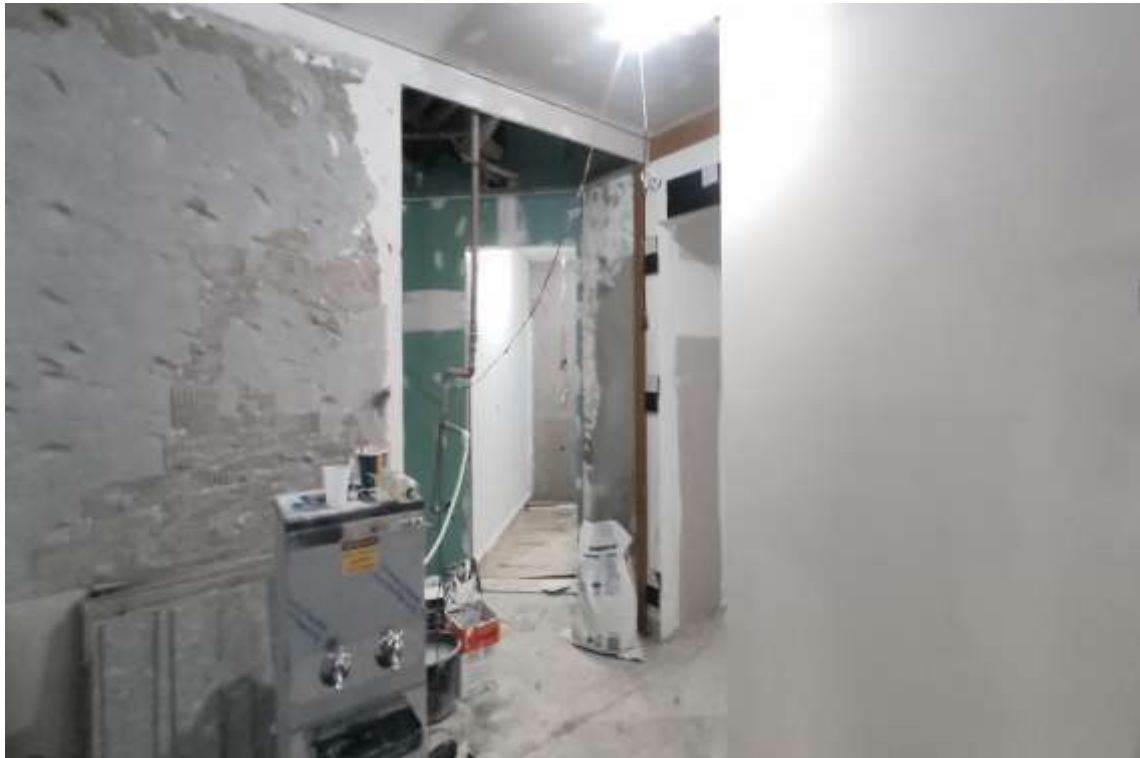
Conjunto 21 – situação atual
