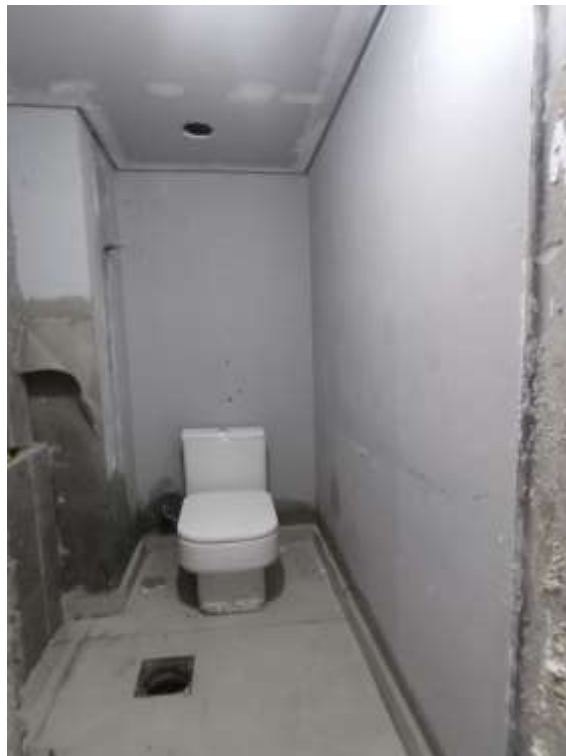
Conjunto 21 – situação atual
