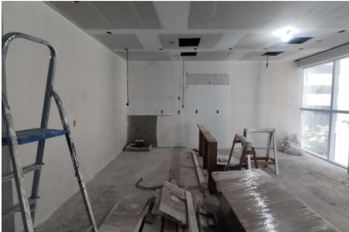
Conjunto 21 – situação atual
