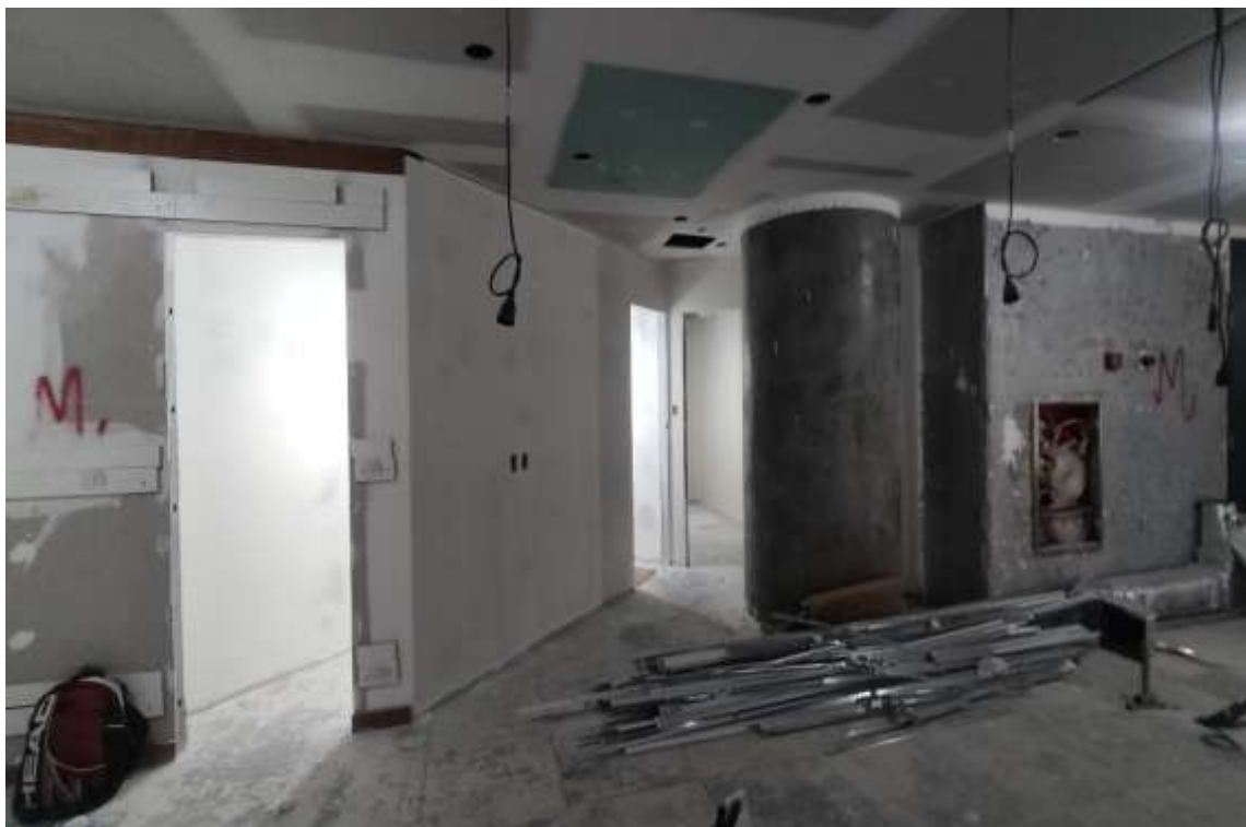
Conjunto 21 – situação atual
