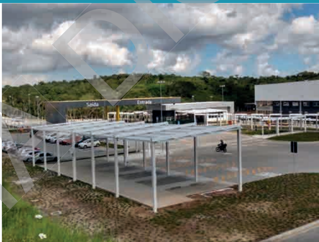
VISTA DA PORTARIA
