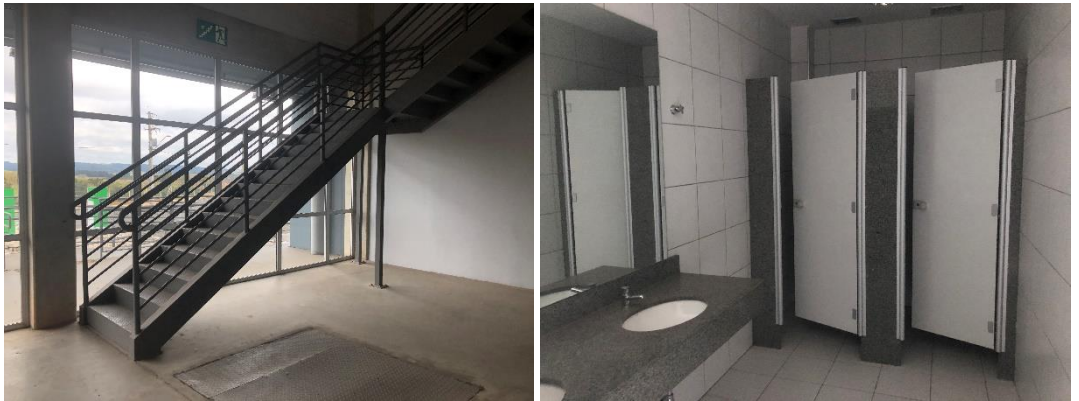
VISTA INTERNA DO GALPÃO – MÓDULO 5
