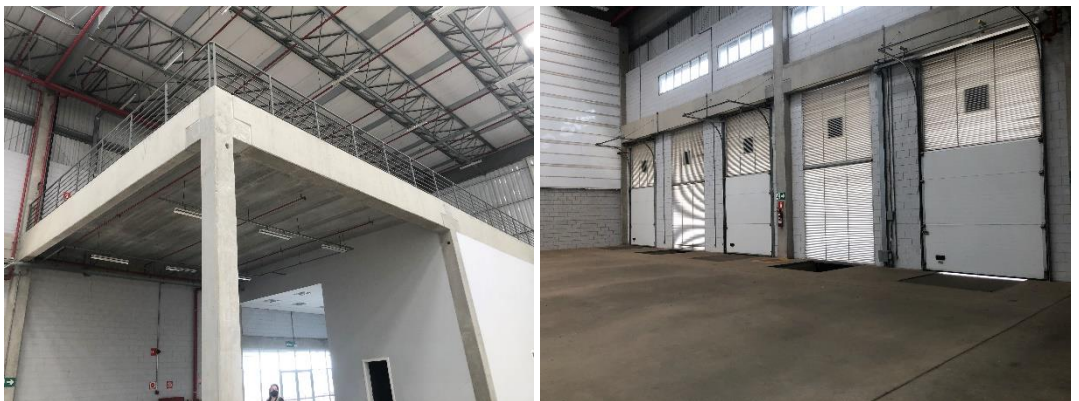
VISTA INTERNA DO GALPÃO – MÓDULO 5
