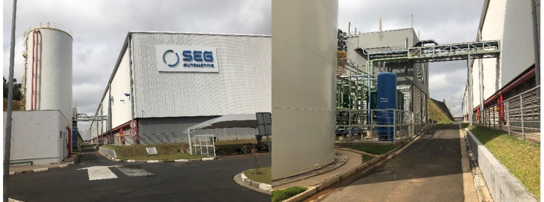
TORRE D'ÁGUA DO CONDOMÍNIO E CENTRAL DE ÁGUA GELADA (SEG AUTOMOTIVE)
