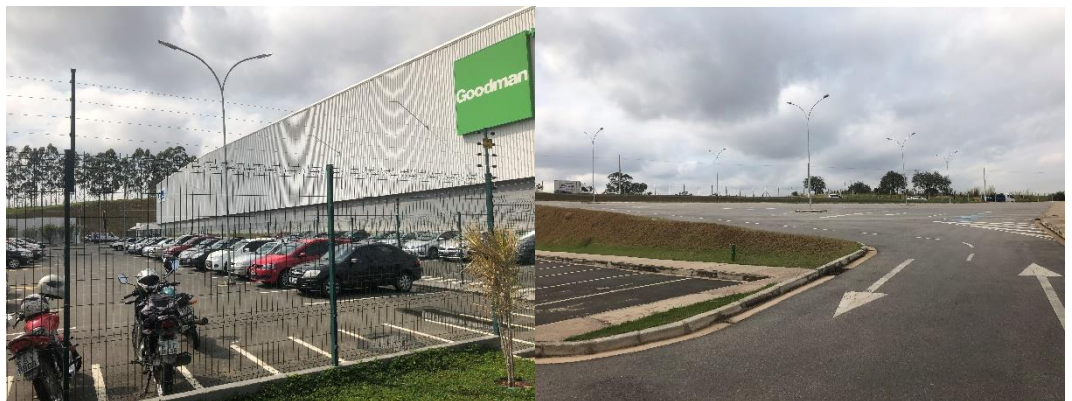
ESTACIONAMENTO PARA FUNCIONÁRIOS
