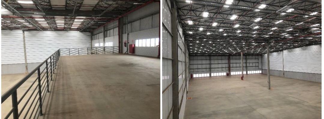
VISTA INTERNA DO GALPÃO – MÓDULO 5 (VAGO)
