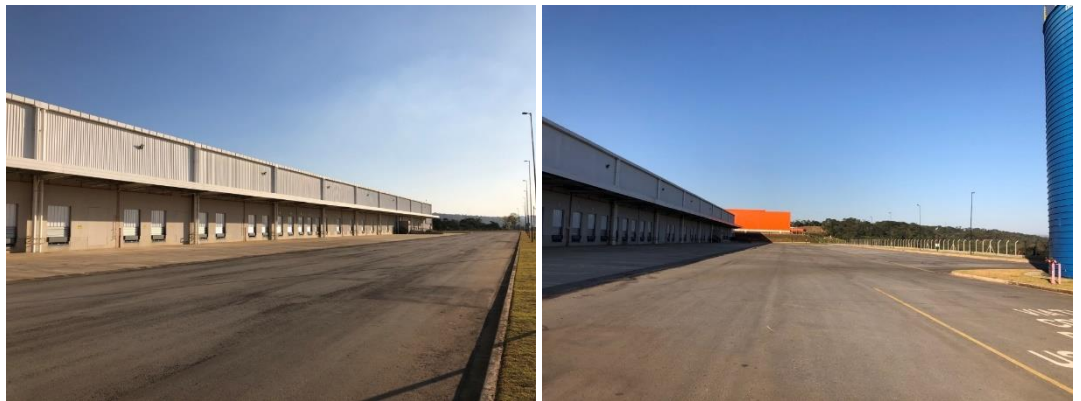
VISTA EXTERNA DO GALPÃO
