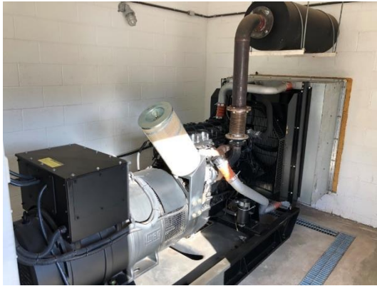
GERADOR E TANQUE DE DIESEL
