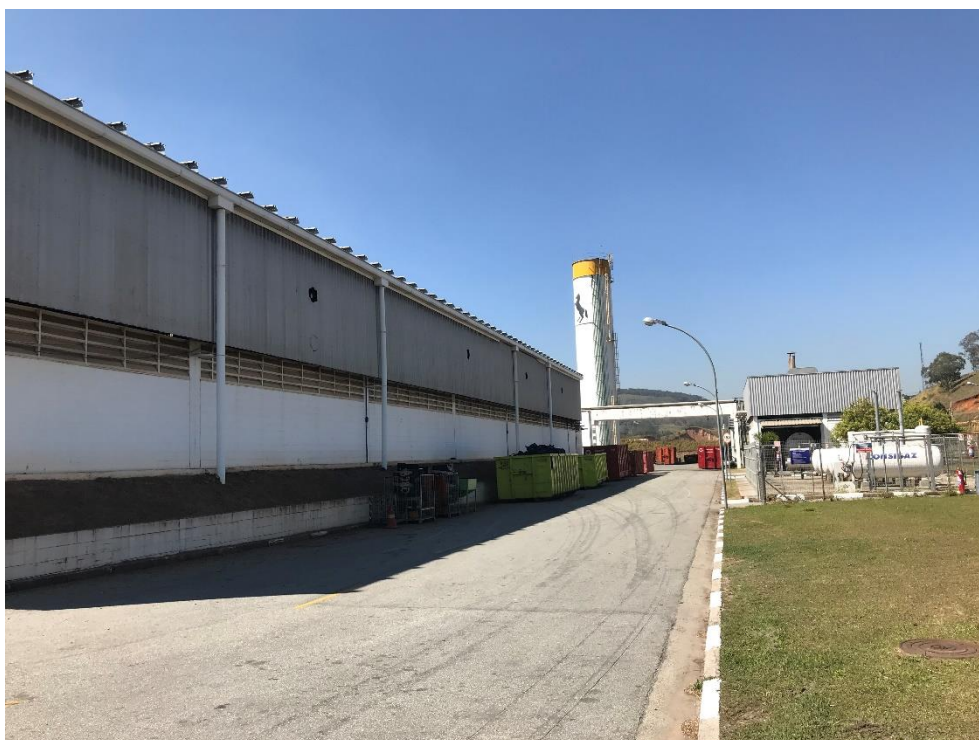
Vista geral do imóvel
