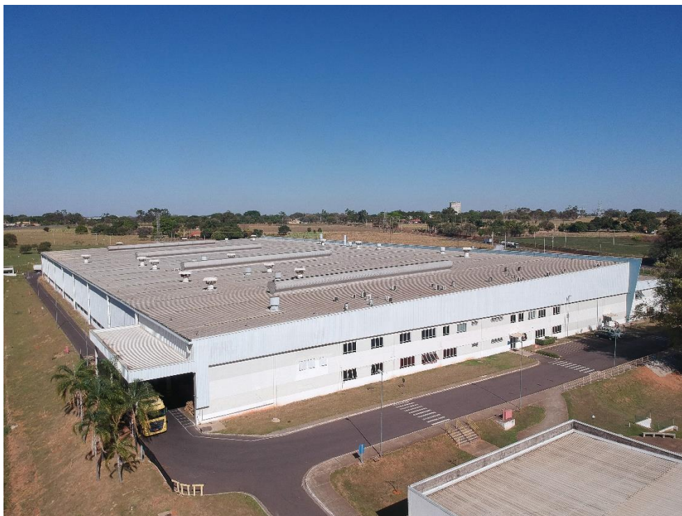
Vista aérea do galpão principal
