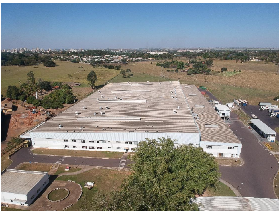
Vista aérea do galpão principal
