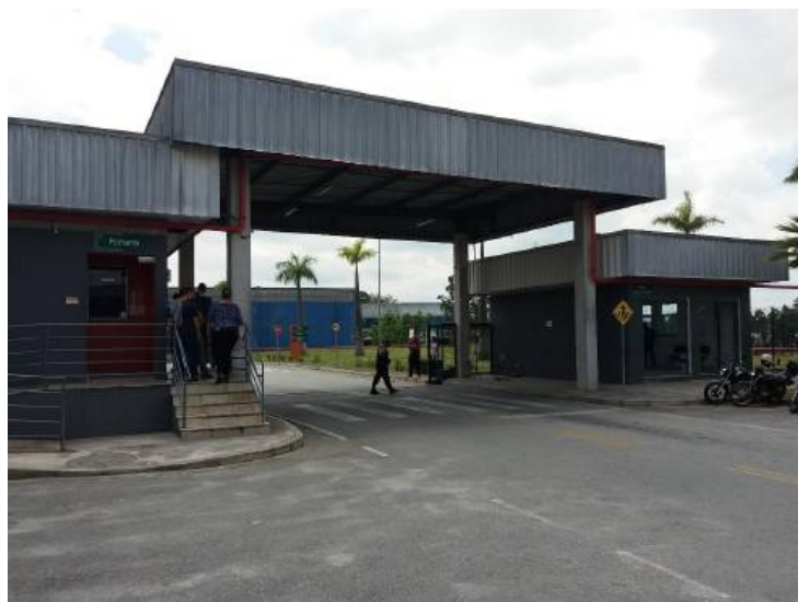
Portaria de acesso
