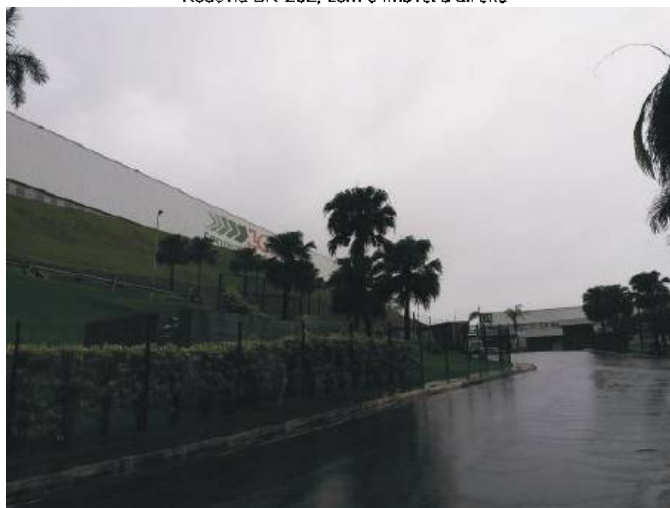
Rodovia BR-262, com o imóvel à esquerda
