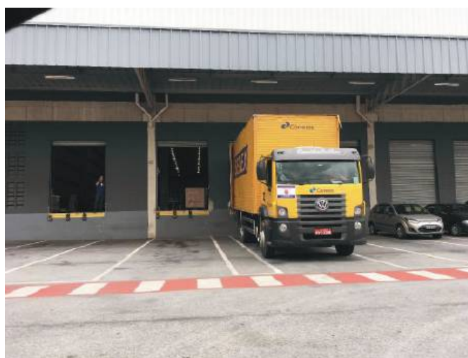
Área de galpão e marquise
