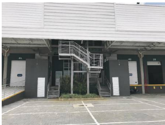
Fachada do galpão
