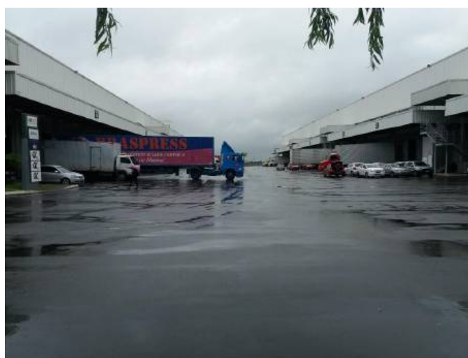
Área de manobra e docas do imóvel
