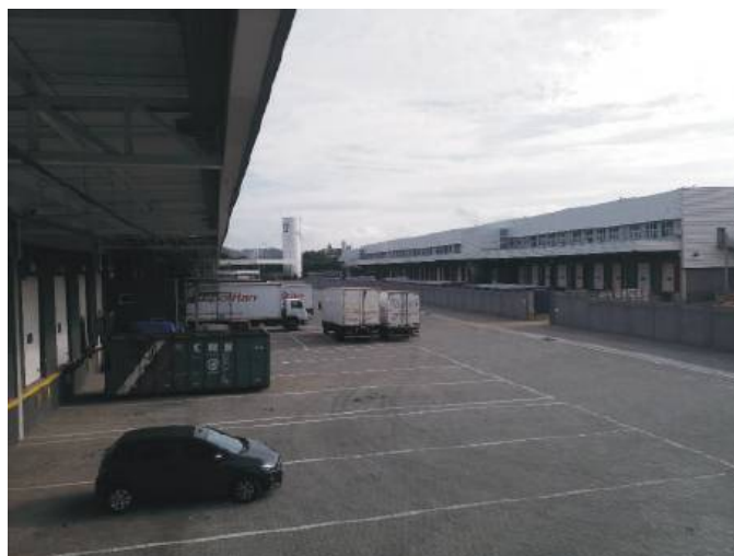
Área de galpão e marquise
