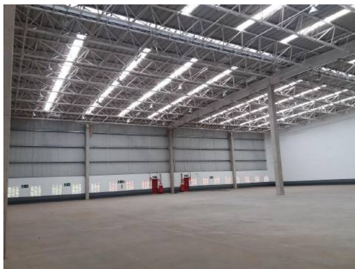
Vista interna do imóvel
