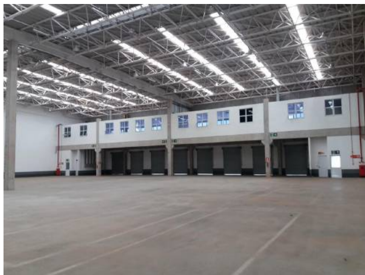
Vista interna do imóvel
