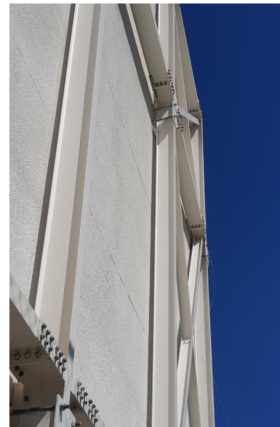
Restituição da Alvenaria do Chiller
