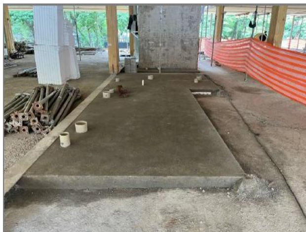
Contrapiso segundo pavimento
