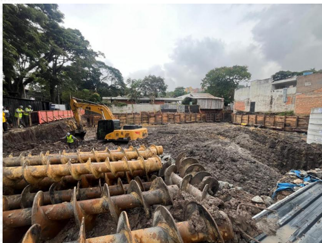
Trados da perfuratriz e corte de talude
