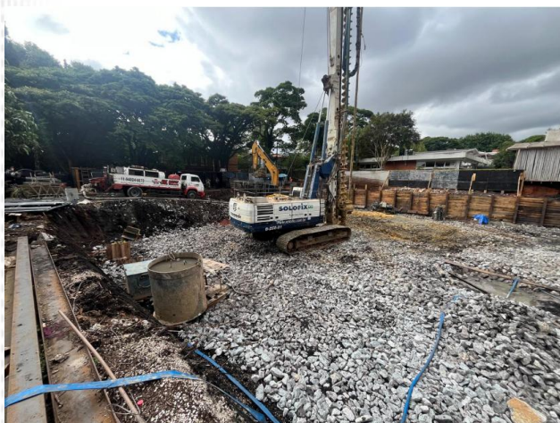
Poço de drenagem provisório e perfuratriz executando estacas
