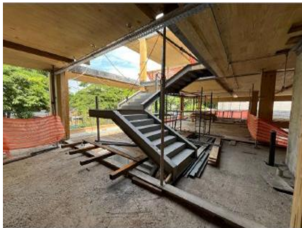
Montagem de escada metálica
