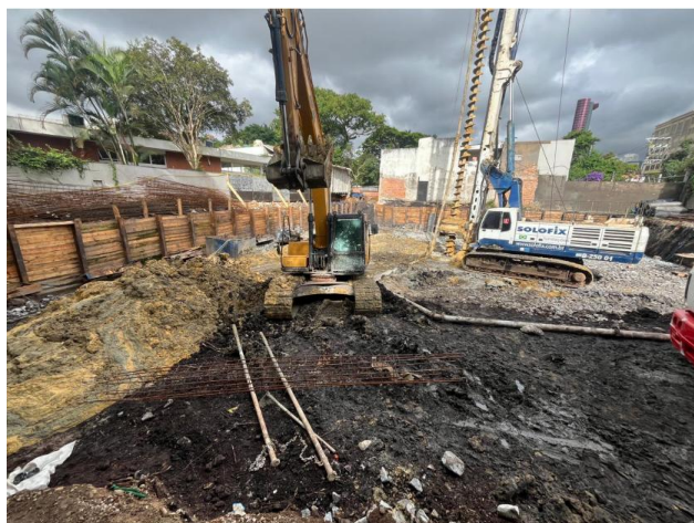
Perfuração de estacas e apoio para remoção de solo residual
