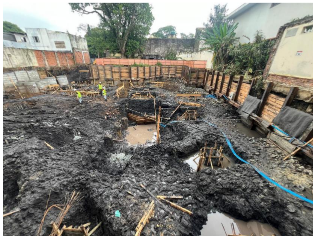
Arrasamento de estacas e formas para blocos
