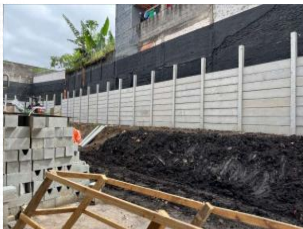
Execução de muro de divisa pré-moldado
