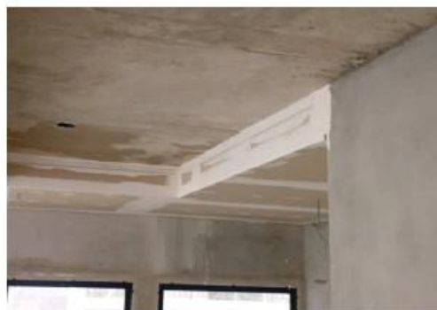
FORRO DE GESSO 10º PAVIMENTO
