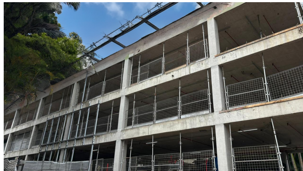
FOTO DA OBRA
