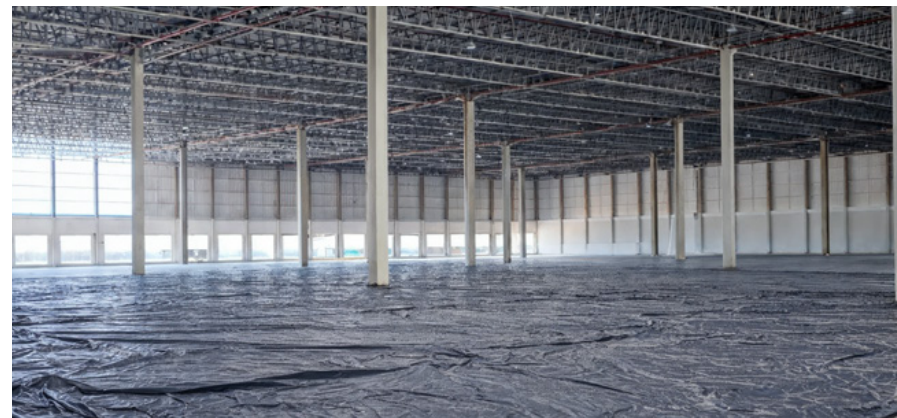
Fechamento Perimetral Cobertura
