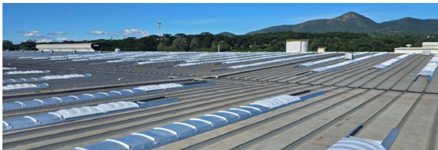
Cobertura do Galpão - Renault
