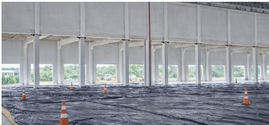
Fechamento de Alvenarias Mezanino
