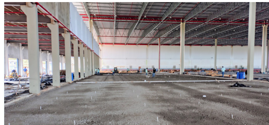
Concretagem do Piso do Galpão
