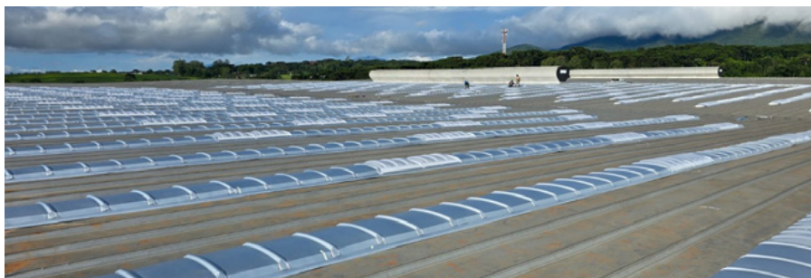
Cobertura do Galpão - Renault
