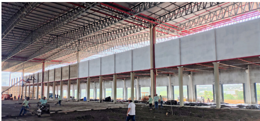
Execução de Alvenaria Perimetral Mezanino
