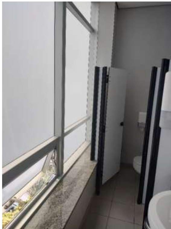
Conjunto nº 41 – sanitário
