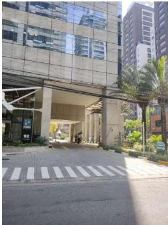
Acesso de veículos – área externa
