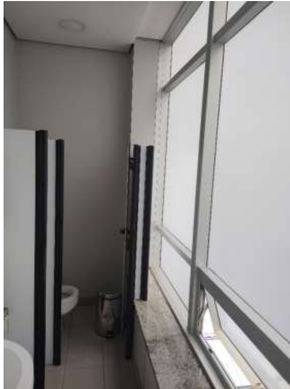
Conjunto nº 41 – sanitário
