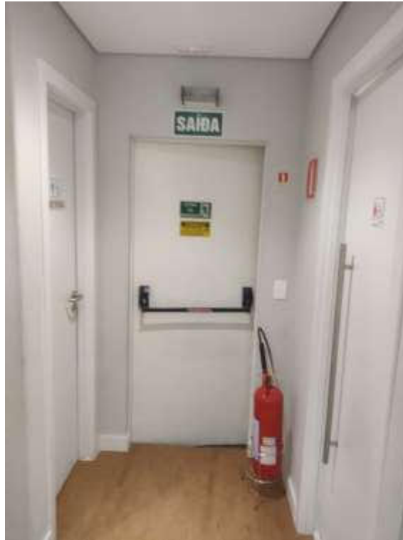
Conjunto nº 11 – circulação e saída de emergência
