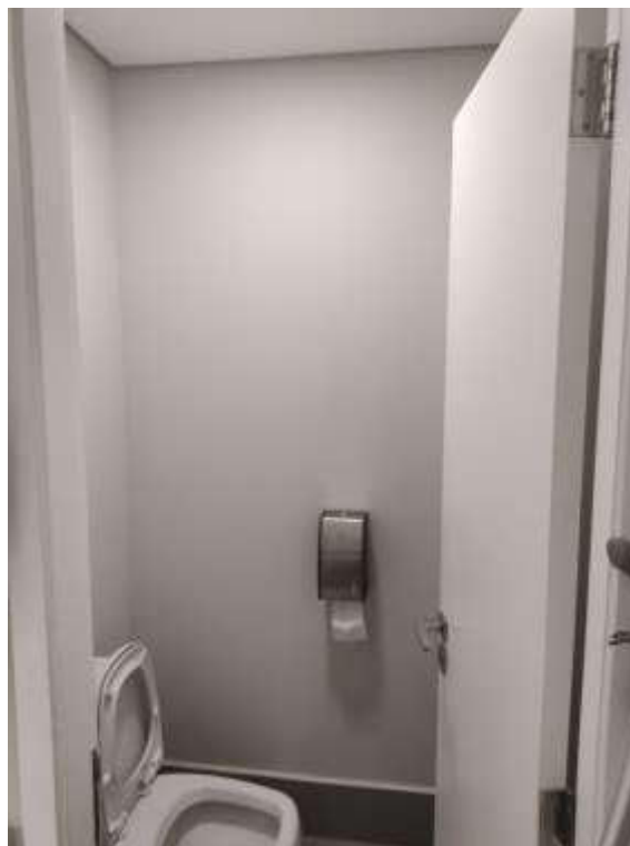
Conjunto nº 31 – sanitário
