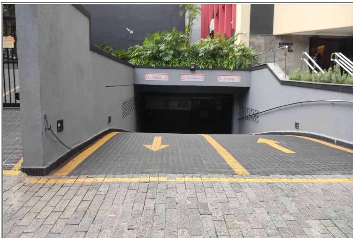
ACESSO AO SUBSOLO
