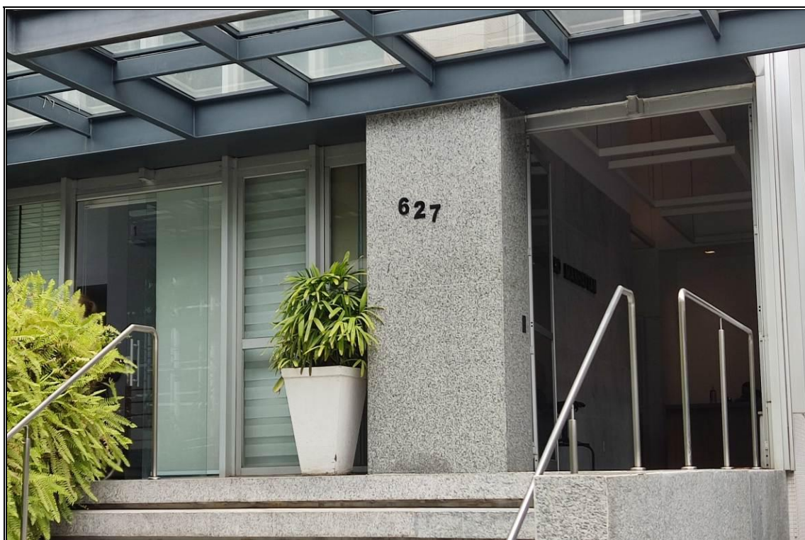
ENTRADA DO EDIFÍCIO
