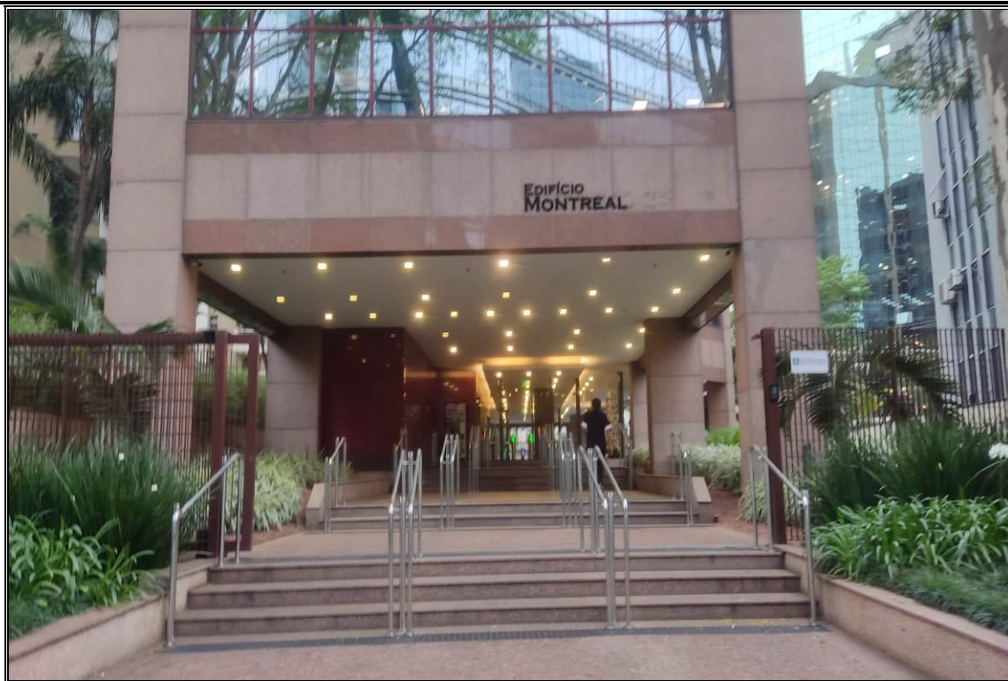
ENTRADA DO EDIFÍCIO
